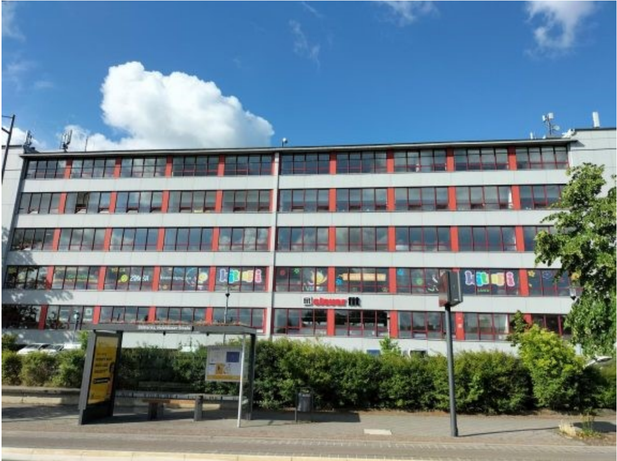
Bürogebäude mit Haltestelle für Tram Linie 4 und Bus Linie 74
